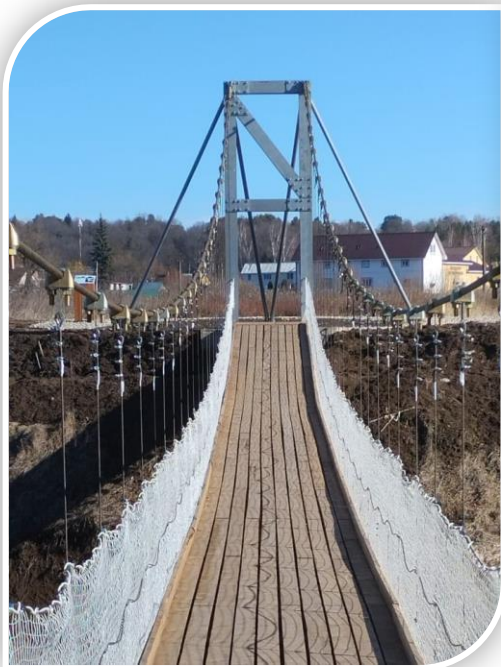
Пешеходный мост через реку Тарусу
