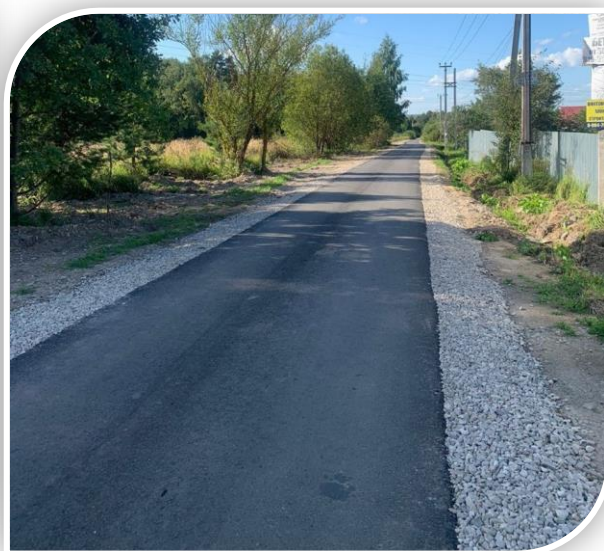
Ремонт дороги в д. Ильинское
