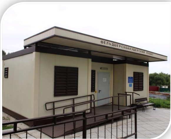
Установлены 5 новых модульных зданий ФАП
